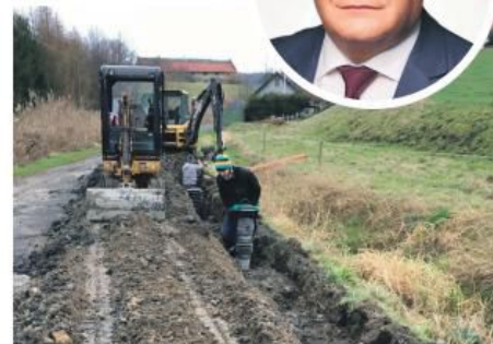
Budowa sieci kanalizacyjnej w Świątku
