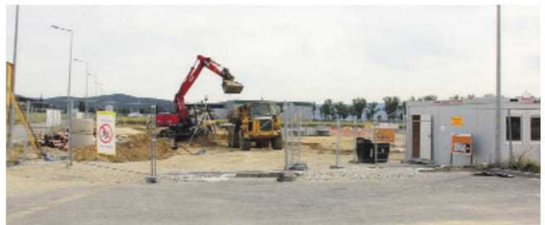
Teren budowy zakładu „Wessel-Poliamid”
