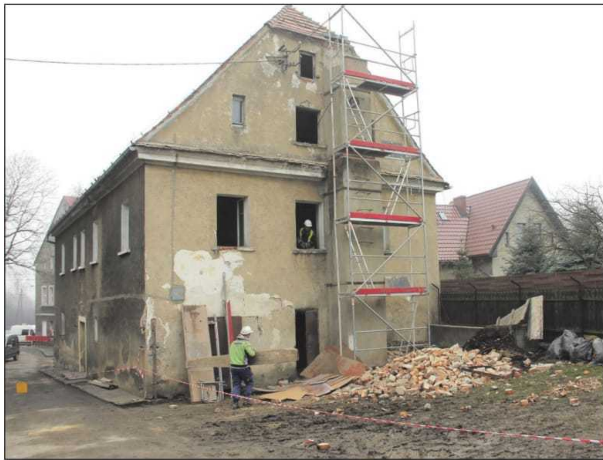
W Szalejowie Górnym rozpoczęła się adaptacja budynku po szkole na mieszkania
