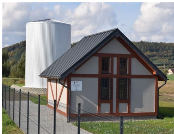
Rysunek 19. Stacja uzdatniania wody
