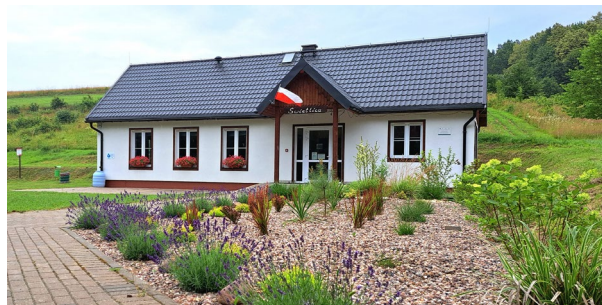
Rysunek 14. Świetlica wiejska w Marcinowie.
