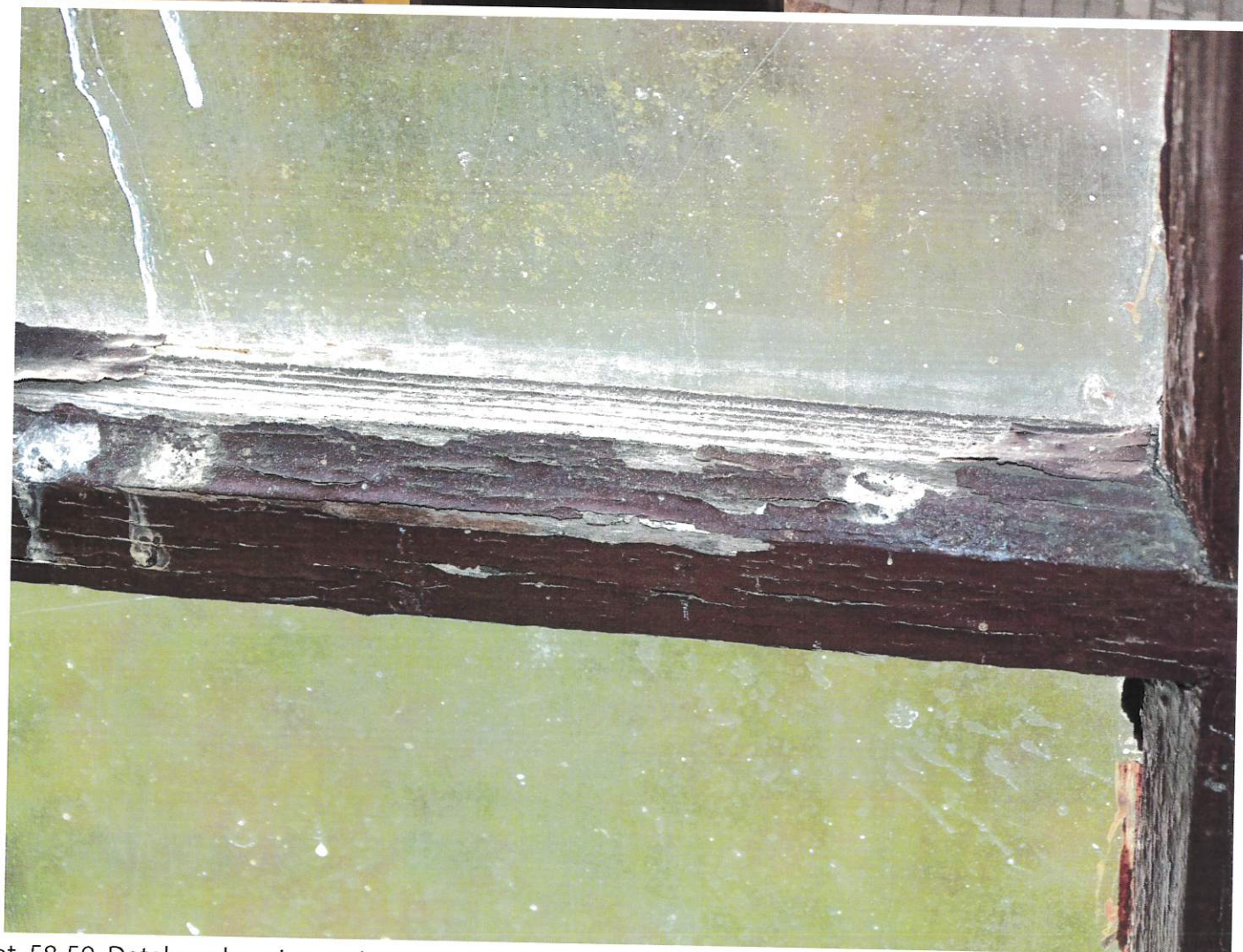
Fot. 58-59. Detale pokazujące zniszczenia zabytkowej stolarki kościoła p.w. św. Katarzyny w Starym Wielisławiu. Widok od wewnątrz. Stan zachowania lutego 2023 r.
