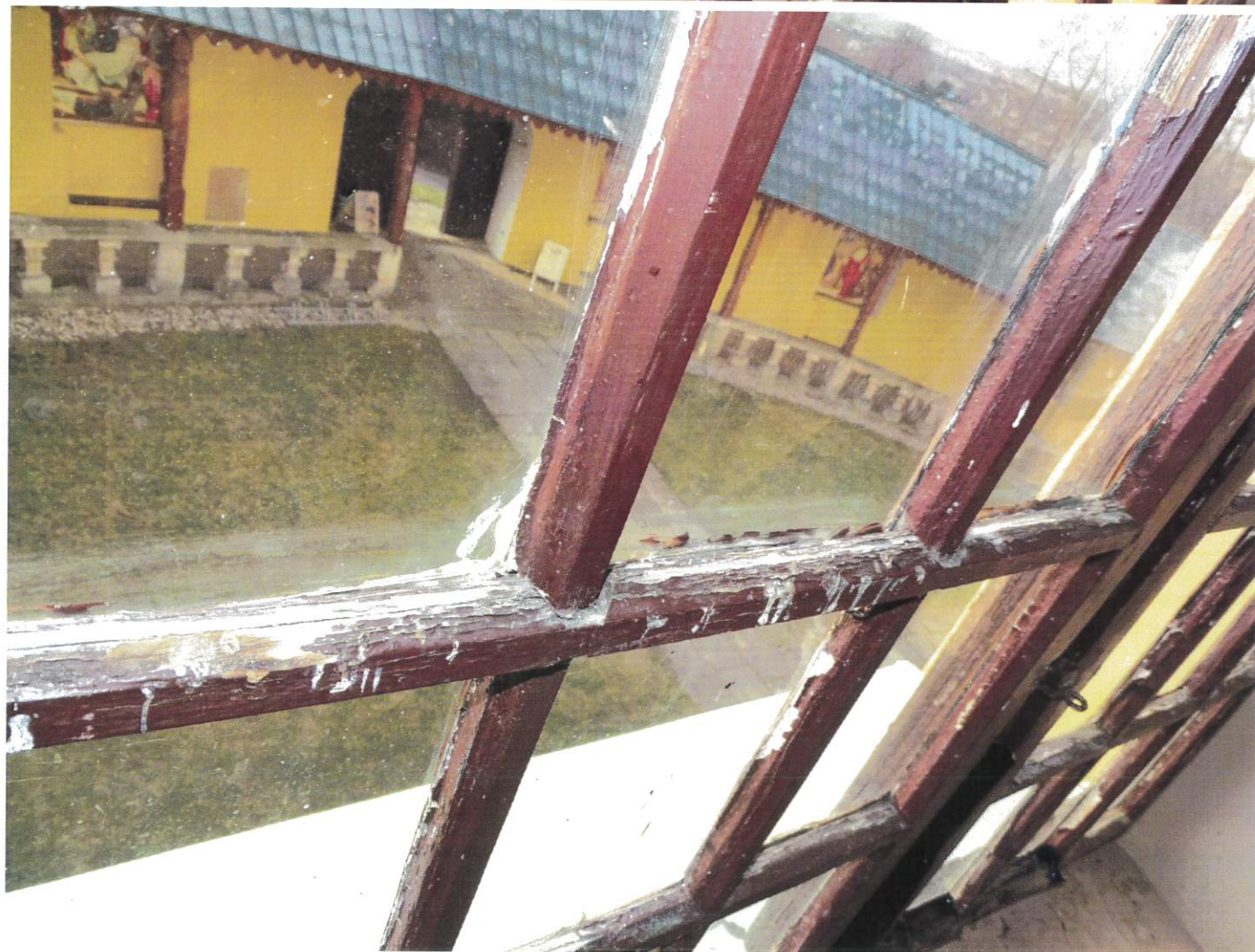
Fot. 54-55. Detale pokazujące zniszczenia zabytkowej stolarki kościoła p.w. św. Katarzyny w Starym Wielisławiu. Widok od wewnątrz. Stan zachowania lutego 2023 r.
