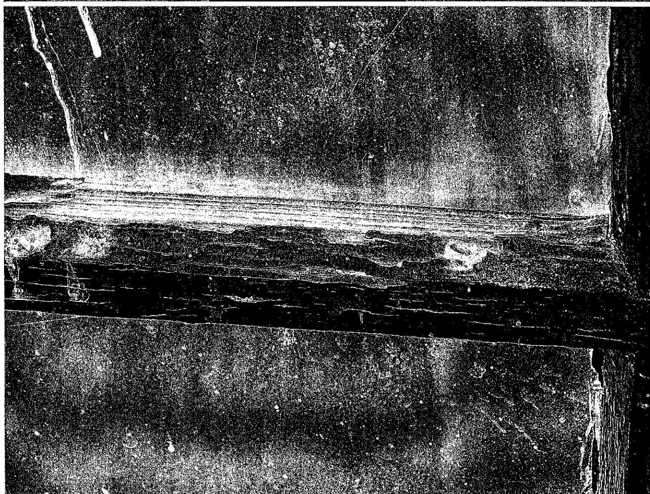
Fot. 58-59. Detale pokazujące zniszczenia zabytkowej stolarki kościoła p.w. św. Katarzyny w Starym Wielisławiu. Widok od wewnątrz. Stan zachowania luty 2023 r.
