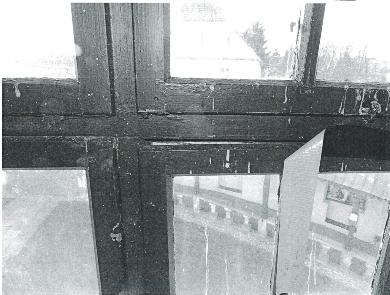
Fot. 56-57. Detale pokazujące zniszczenia zabytkowej stolarki kościoła p.w. św. Katarzyny w Starym Wielisławiu. Widok od wewnątrz. Stan zachowania luty 2023 r.
