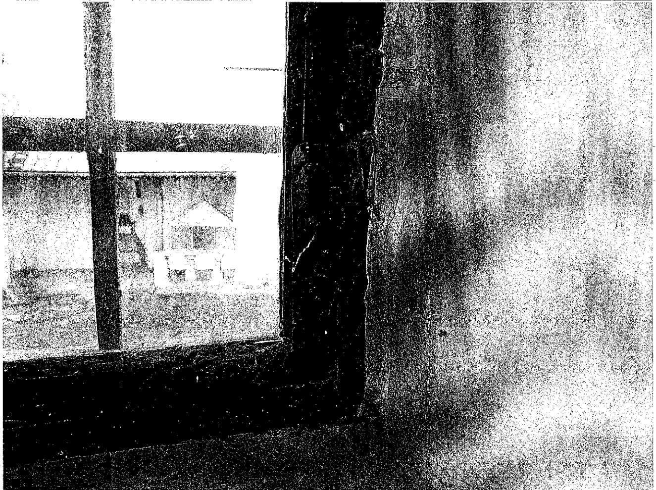
Fot. 60-61. Detale pokazujące zniszczenia zabytkowej stolarki kościoła p.w. św. Katarzyny w Starym Wielisławiu. Widok od wewnątrz. Stan zachowania lutego 2023 r.
